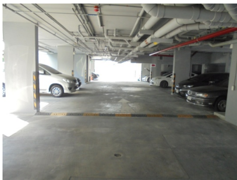
ภาพที่ 4-22 แนวท่อระบายน้ำและฝาท่อเป็นฝาคอนกรีต
